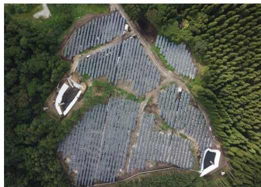
信濃町太陽光発電所
